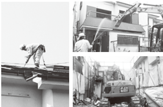
▲解体作業風景(一部)
